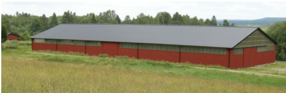
Ridhallen, även kallad maskinhallen. I bakgrunden till vänster syns stallet.
